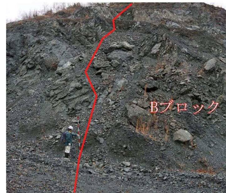
写真-27・28 (H25年度) 東のり面、最下部。Bブロック の末端部。移動体は、岩塊状、 角礫状を呈する。
