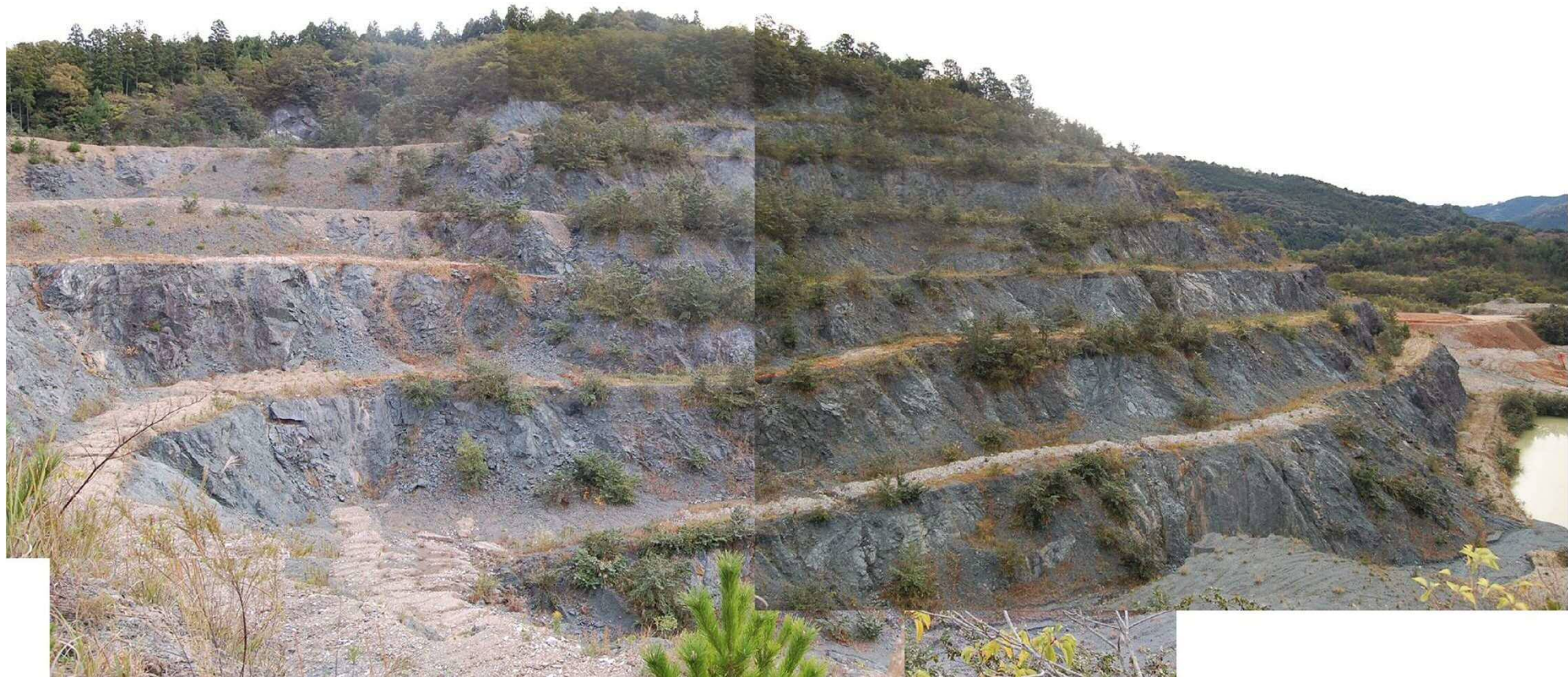
調査地全駅（H29年度） 小段部に客土が施工されてい るが、地すべり変状は見られ ない。
