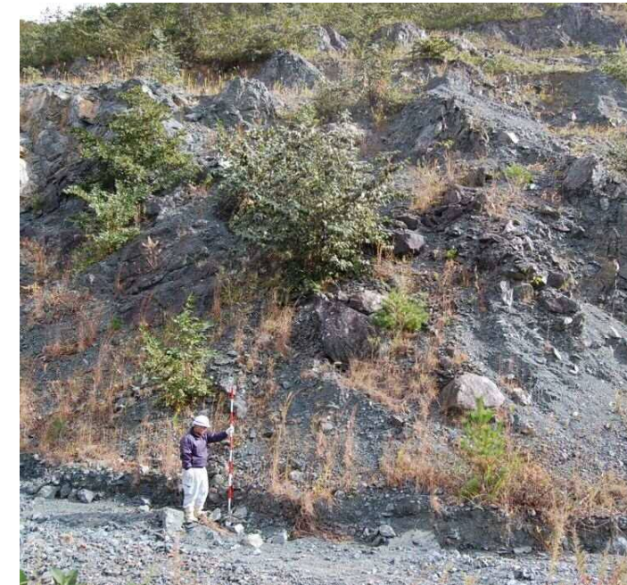
写真-27・28 (H29年度) 表層土砂の移動は確認される が、変状はない。
