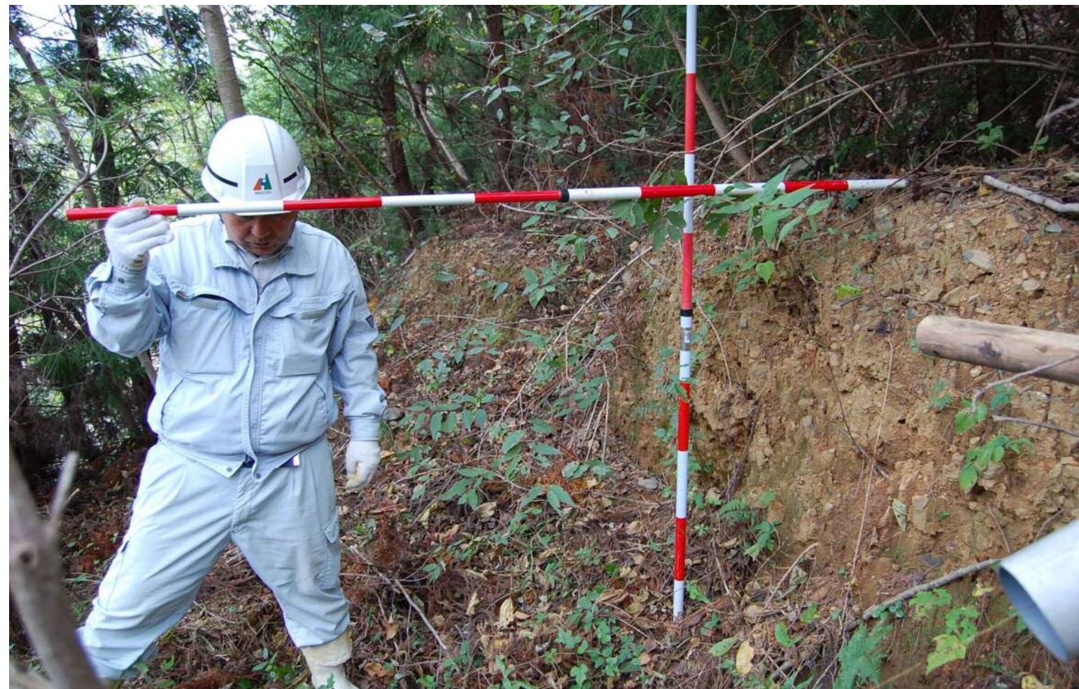
写真-6 (H29年度) 段差の拡大などの変状は見ら れない。
